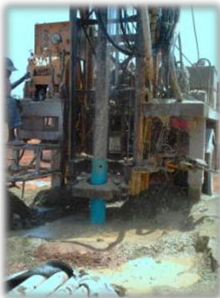
finalement, après trois tentatives et de recherches, l'eau a été trouvée. Le forgage est réalisé et la pompe est installée, ont construit les canalisations pour permettre d'abreuver le bétail et d'arroser le futur champs agricole. Le puits offre de l'eau pour le centre et les habitants de LANGHESANDOGO, le lieu où se trouve le Centre KOGLI\_BA.
