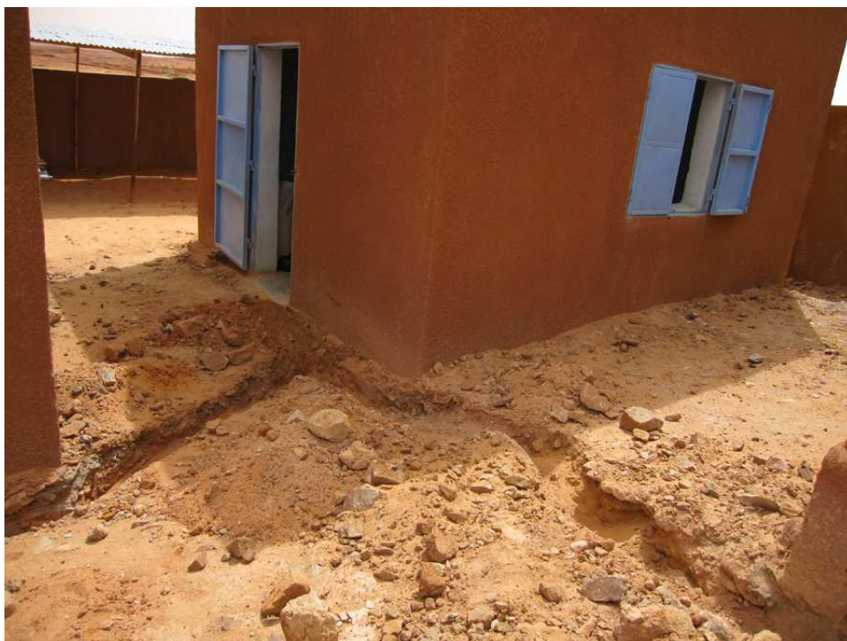
Nelle scanalature passeranno i fili elettrici
