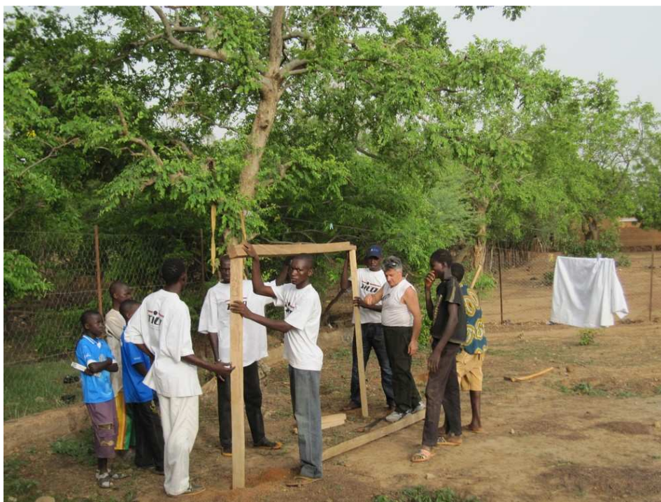
Inizio lavori dell'hangar
