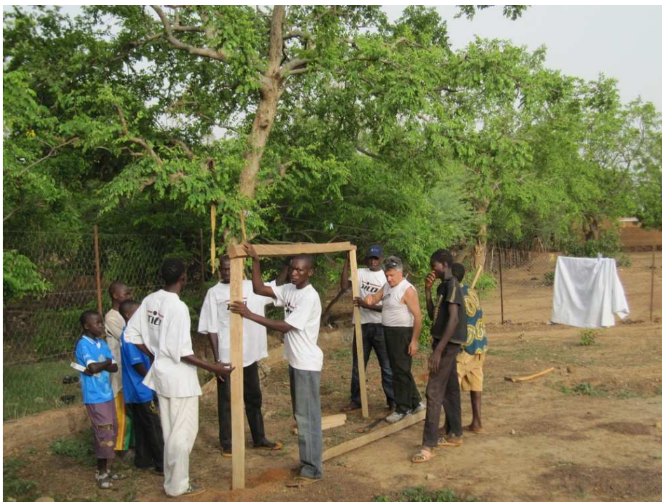
Le début des travaux du hangar
