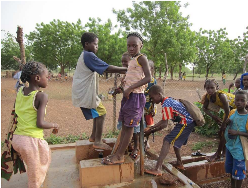
Puits avec pompe manuelle
