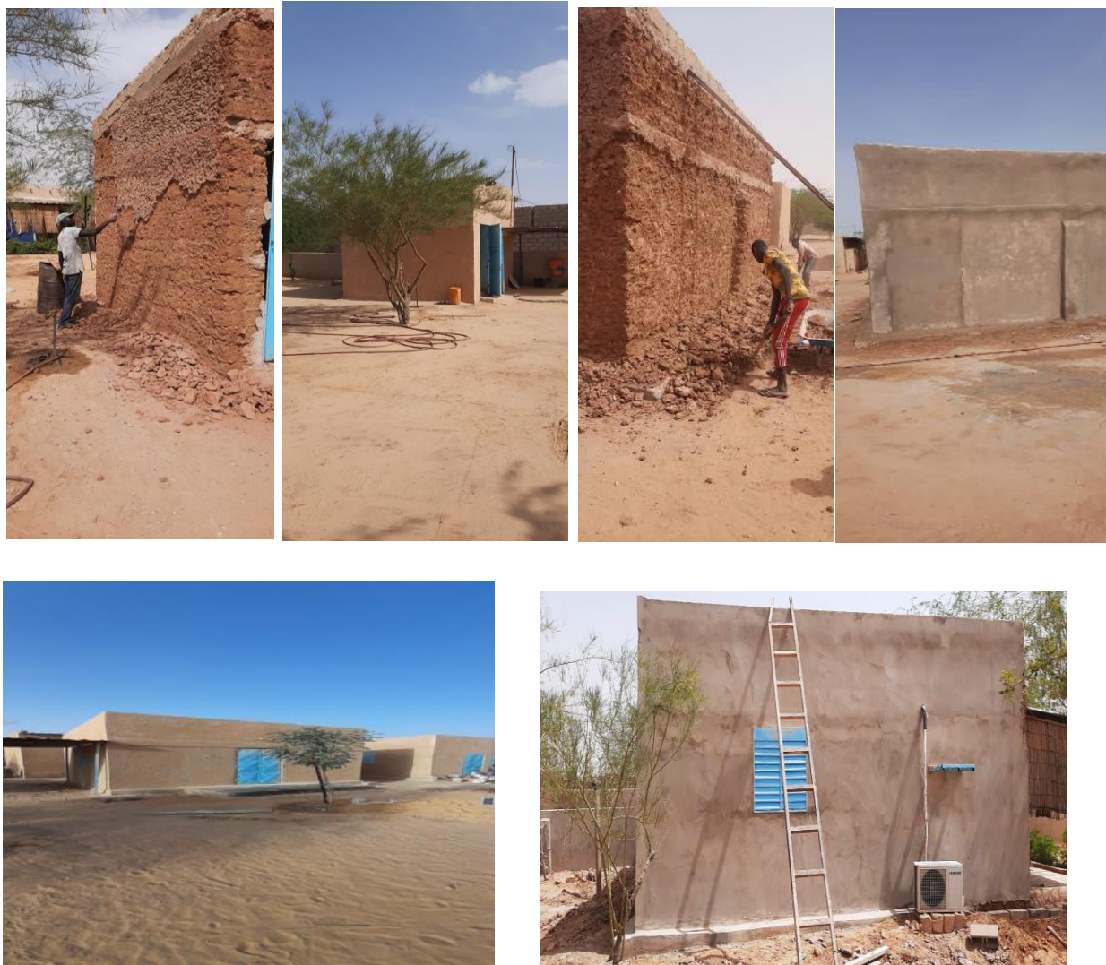
Lavori nelle strutture
